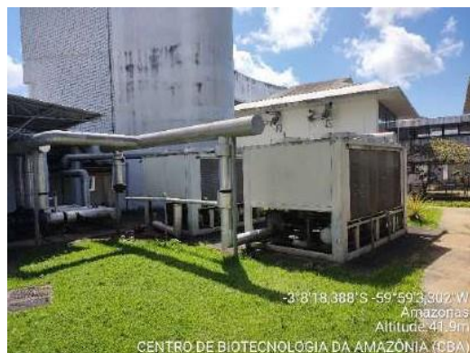
Foto 25- Centrais de ar condicionado sem
