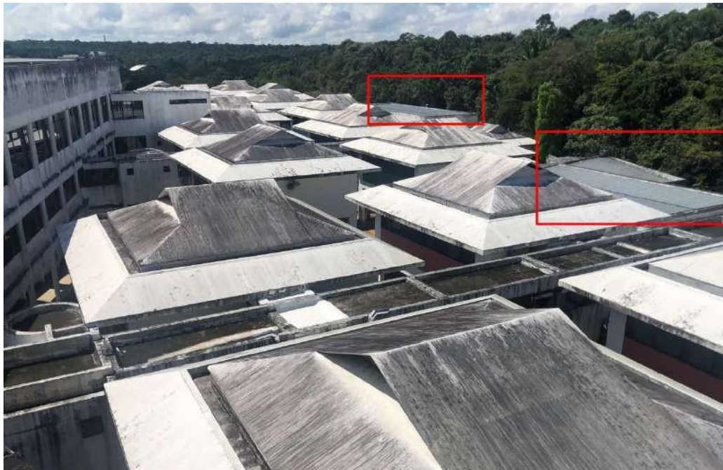
Figura 3 - Cobertura metálica existente
