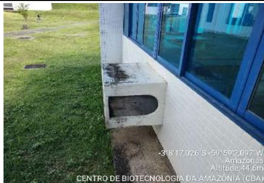
Foto 9- Infiltrações nas esquadrias, calçadas danificadas
