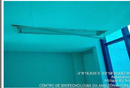
Foto 04 - Luminárias danificadas
